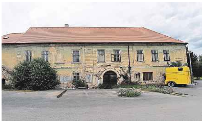
Bez věže, ale s novou střechou Stav zámčeku je sice špatný, nicméně výrazné degradaci by měla zabránit relativně nová střecha.
